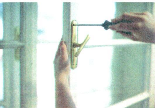
Mitunter werden historische Beschläge nach Originalen oder Zeichnungen nachgebaut
