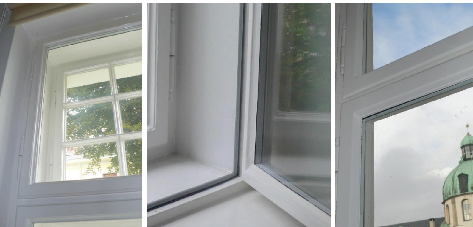
Isolierglaseinbau unter Bewahrung der bestehenden Innen- und Außenansichten
