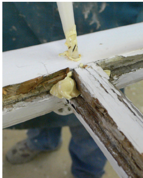
Holzreparatur und Ausleimen von losen Holzverbindungen mit Epoxy - Hochdruckinjektion (Sikkens)
