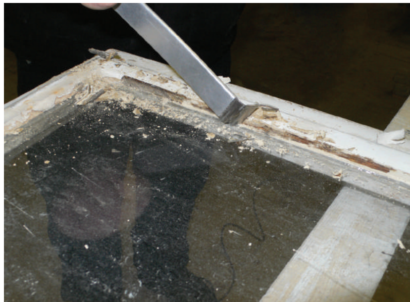
Kittreparatur mit Infrarot-Technik
