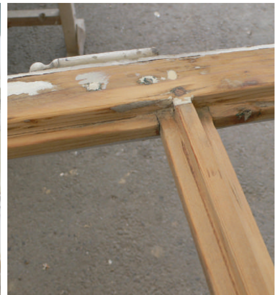
Holzreparatur und Ausleimen von losen Holzverbindungen mit Epoxy - Hochdruckinjektion (Sikkens)
