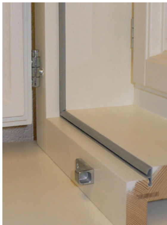
Einfräsen und montieren von ZP-Falzdichtungen
