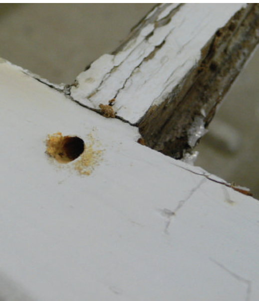
Holzreparatur und Ausleimen von losen Holzverbindungen mit Epoxy - Hochdruckinjektion (Sikkens)
